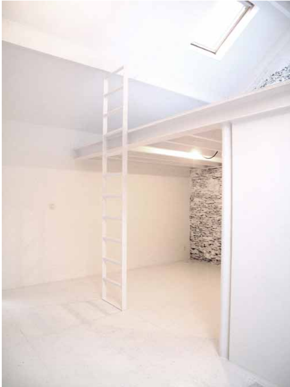
Habitation LAR, 2009 Espace intérieur, R+2 après réalisation. Maçonnerie pierre de schiste, acier, plancher OSB, enduit de plâtre © adn architectures
