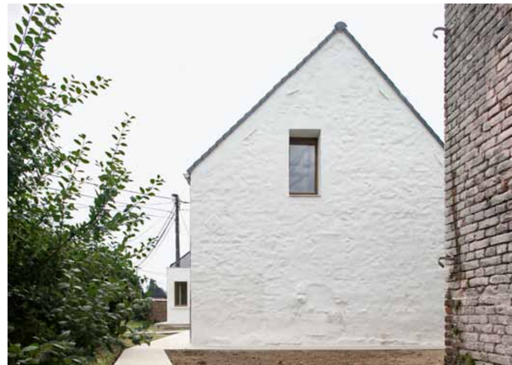
Habitation NSV, 2010. Pignon extérieur Maçonnerie en moellon, enduit à la chaux © Filip Dujardin
