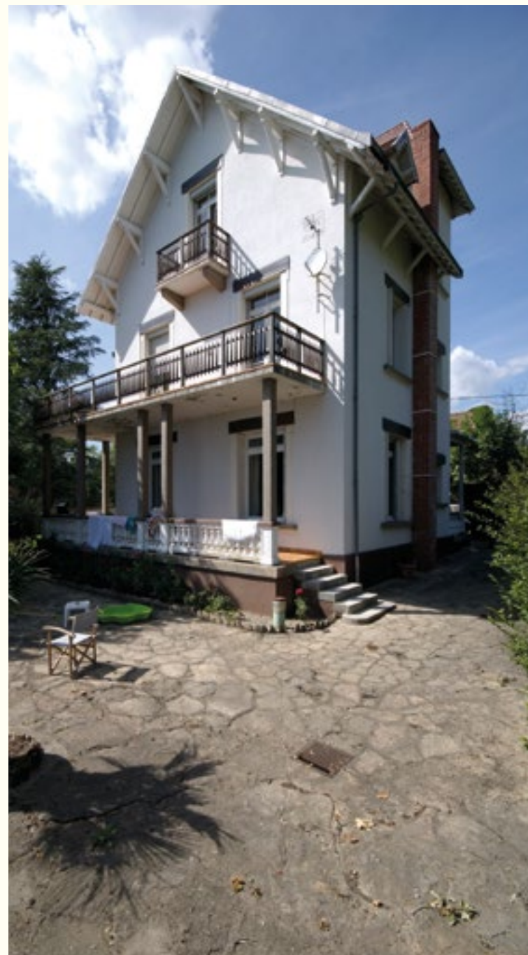
La maison du Lac. Transformation d'une villa existante et construction de quatre extensions (cuisine, balcons, chambres et un studio de musique), Châtillon, Lac du Bourget, Savoie, France, 2010.
