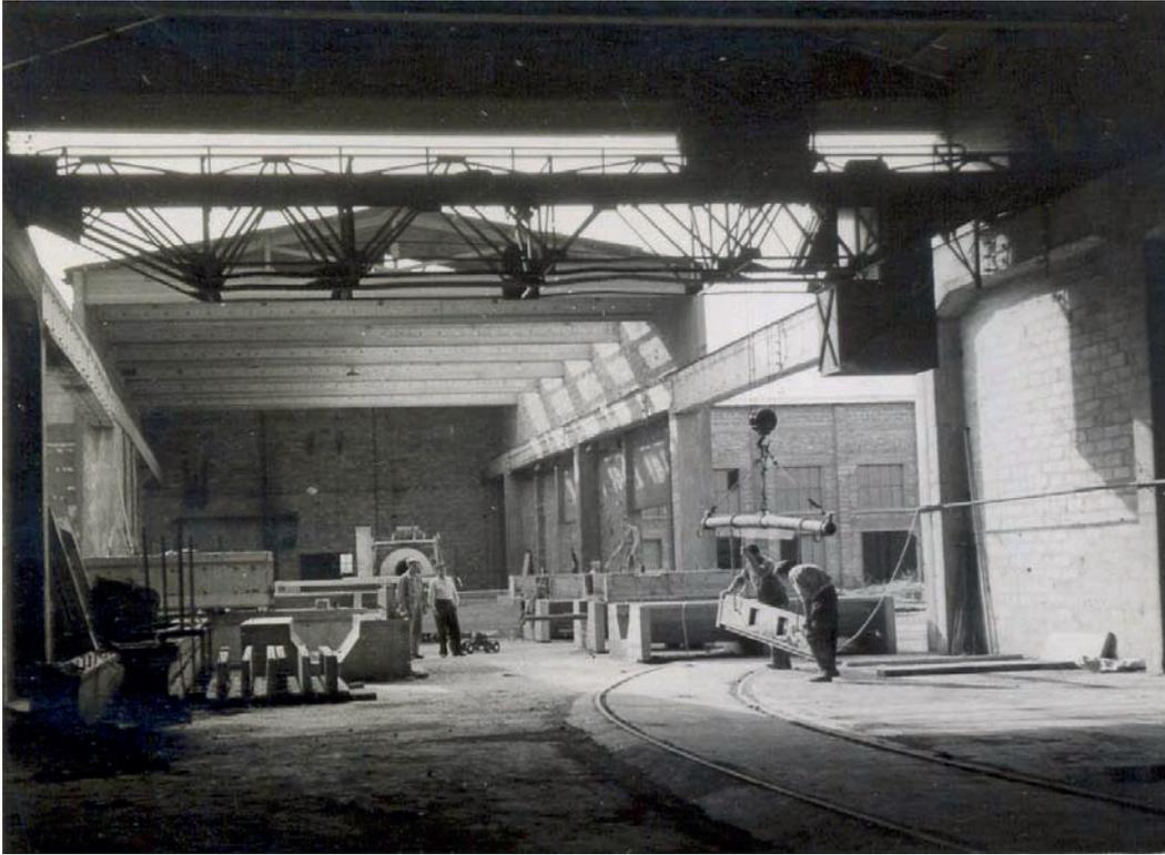
Figure 2. Préfabrication en usine (atelier de fabrication des trumeaux)
