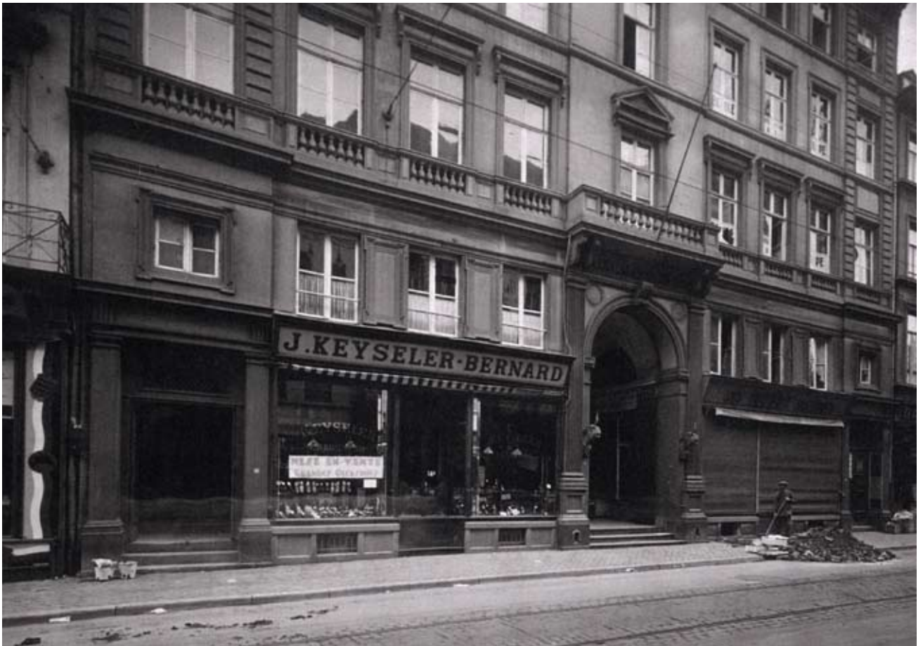
Fig. 3.- Façade rue de l'Université, avant 1934, photographie de l'album de Louis Dabin. © Liège, Société civile du Passage Lemonnier.
