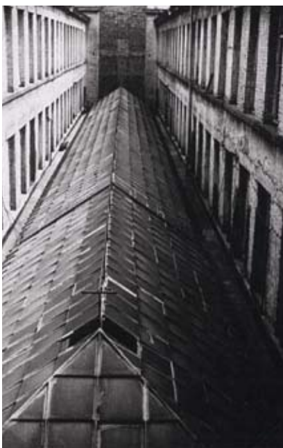
Fig. 6.- Vue de la verrière principale et des étages du Passage Lemonnier, avant 1934, photographie de l'album de Louis Dabin. © Liège, Société civile du Passage Lemonnier.
