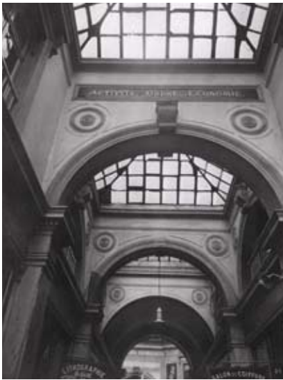
Fig. 9.- Vue intérieure du Passage Lemonnier, petites verrières, avant 1934, photographie de l'album de Louis Dabin.
