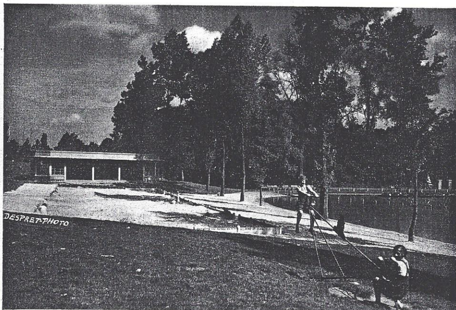
La plaine de jeux de Nivelles. La plage des enfants et l'abri-classe. — Architecte : Maurice Ladrière. Photo Despret.
