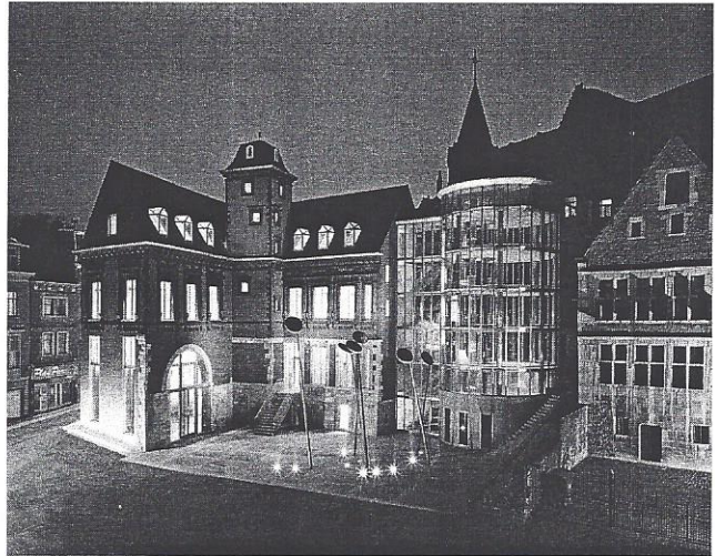
L'hôtel Desoër de Solières à Liège, arch. Bureau d'Architecture Greisch. Photo: Jean-Luc Deru, Daylight, Liège.
