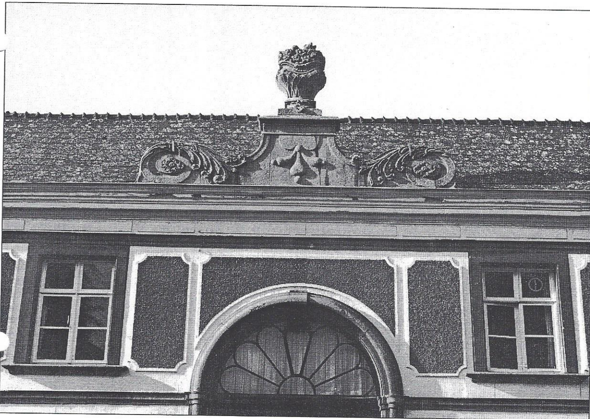
Hôtel de maître, 18e s., (enduit du 19e s.), Rue des Telliers 20 à Mons. Détail de la façade (Photo: Charles Van Calster).
