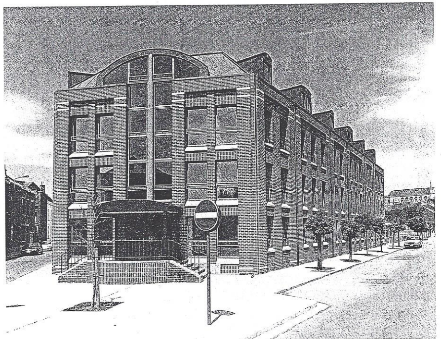
Vue d'ensemble du site avant la rénovation. Photo Barre. Bâtiment «Tutelle» à l'angle des rues A. Legrand et H. Glépin. © Condes.
