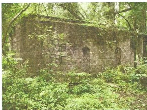
*Ce bloc de béton marque la présence de la Machine d'Extraction, un bobine. Les entrées permettent la visite et le graissage de la machine.*
