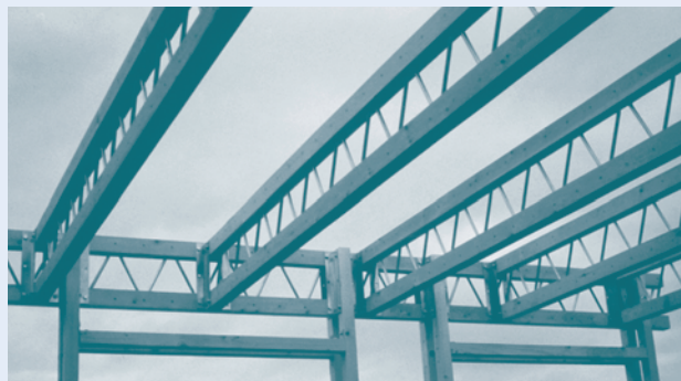
Mise en œuvre des poutres Wirewood® - Photos: © Philippe Jourdan
