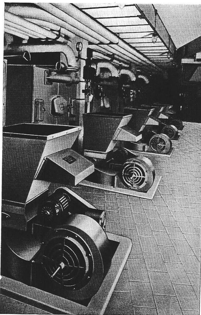
Fig. 16. — Salle de chauffe. Batterie des avant-foyers système Stein.
