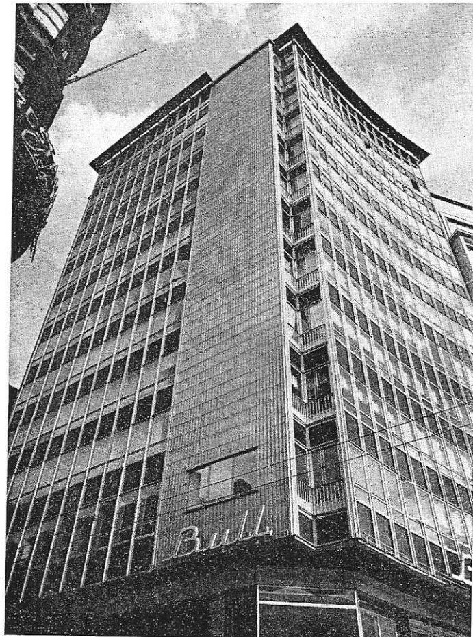
Les façades en aluminium prennent naissance au deuxième étage. Elles reposent sur l'ossature en béton du rez-de-chaussée et du premier, laquelle est recouverte extérieurement de granit de Suède poli.
