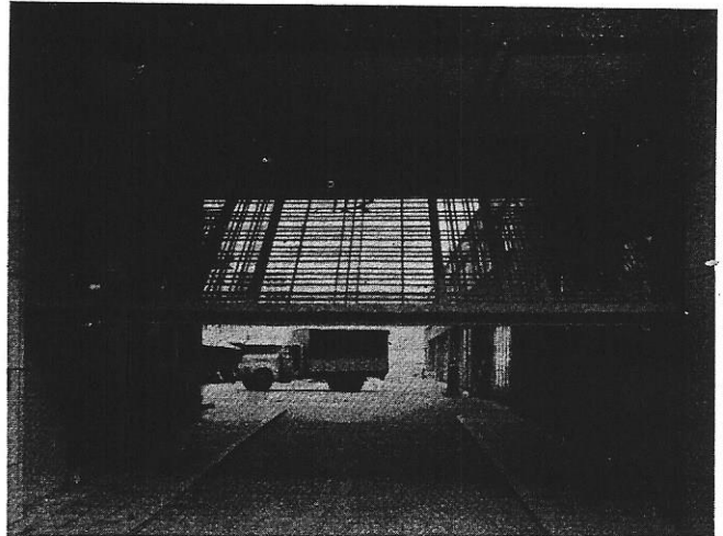
FIG. 18. — LA PORTE BASCULANTE fermant le passage carrossable de la rue de la Sirène. La manœuvre de cette porte se fait électriquement.
