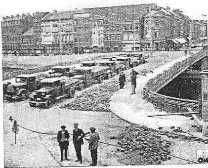
Fig. 684 (ci-dessus). Vue prise pendant les essais du pont.
