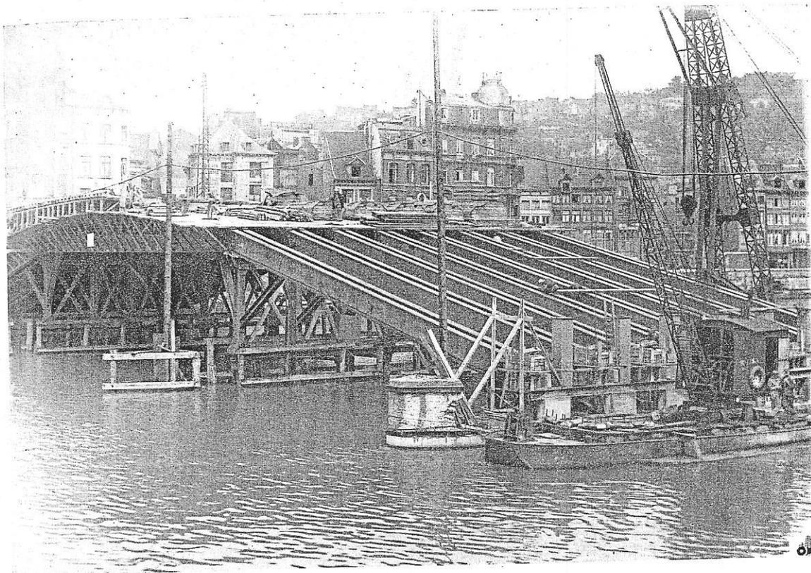
Fig. 459. Vue du cintre en poutrelles H du pont des Arches à Liège.
