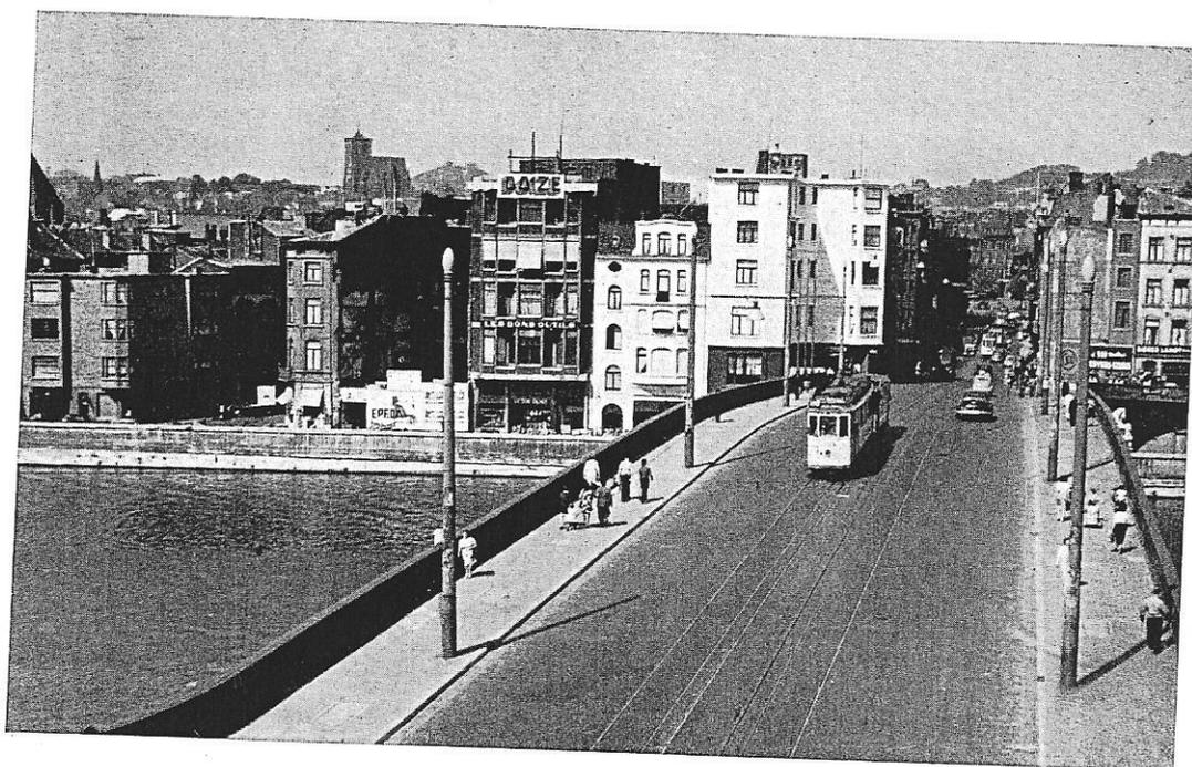
FIG. 2. — LE PONT DES ARCHES vu de face. La chaussée, large de 13<sup>m</sup>50, permet la circulation de quatre véhicules de front.
