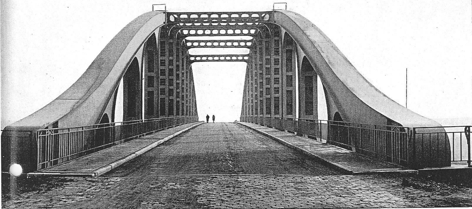
Fig. 624. Pont Vierendeel de Hermalle-sous-Argenteau.
