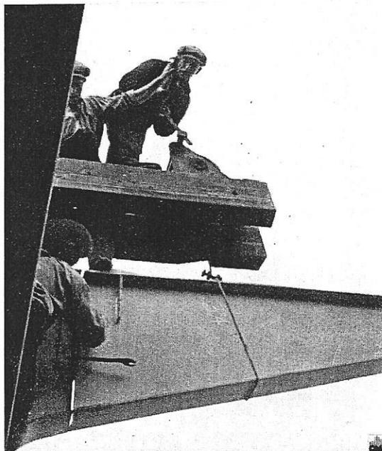
**Fig. 495.** Mise en place d'une console.
