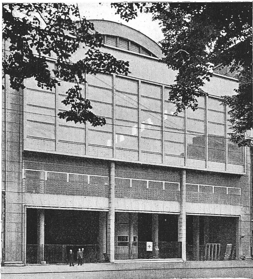
FIG. 1. — LA FAÇADE VERS LA PLACE XAVIER NEUJEAN. Au rez-de-chaussée la gare routière. Au premier étage, mur de verre assurant l'éclairage des vestiaires des scolaires. Au-dessus, l'immense verrière qui souligne l'ampleur du grand hall des bassins.
