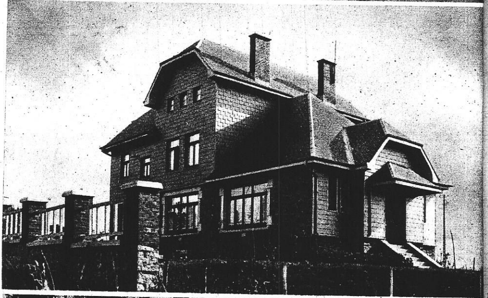
Dispensaire rural, à Neufchâteau. Arch. Miest. Toitures et revêtements de façades en ardoises.
