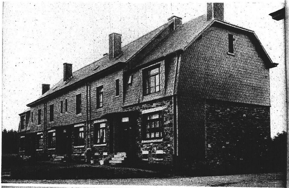
Habitation à bon marché du Foyer Libramontois. Arch. Miest, à Neufchâteau. Toitures et revêtements de façades en ardoises.
