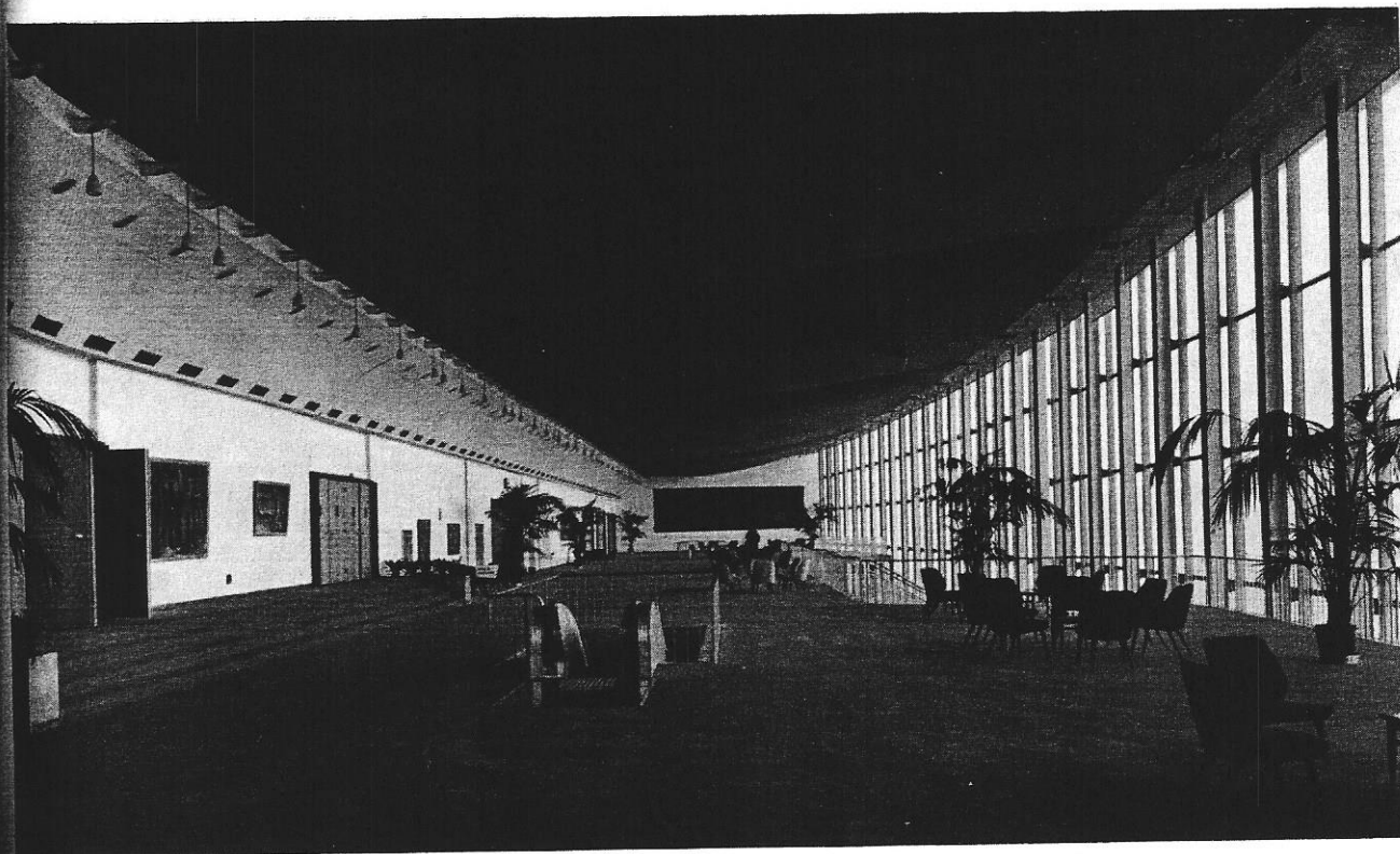
FIG. 1. — LE GRAND FOYER DU PALAIS DES CONGRÈS, À LIÈGE. À gauche, les trois rangées de bouches de pulsion et, à droite, au plafond, les bouches de reprise d'air.
