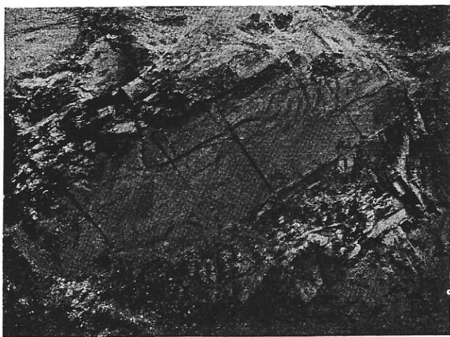
Fig. 9. — Phénomènes tectoniques : diaclases secondaires. La planche représente une partie de la paroi Sud-Ouest de la grande fosse réalisée pour l'établissement des substructions de la tour du monument civil (avant-plan de la fig. 17).
