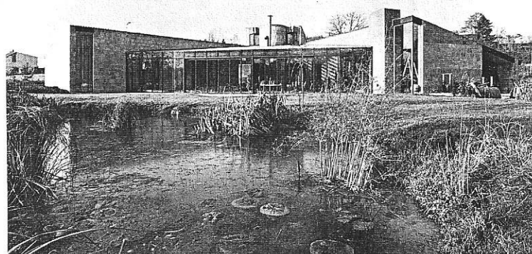
Serre, côté sud
