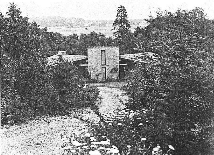
Accès, côté nord
