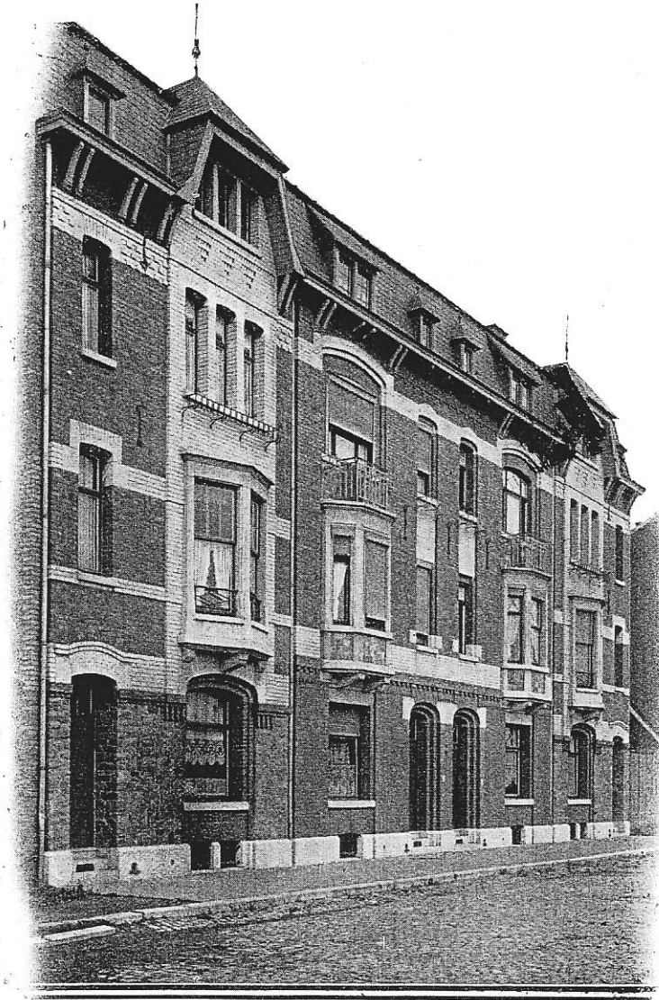
GRUPE DE QUATRE MAISONS, RUE DE LONDRES, A LIÈGE. Architecte : A. Lobet.
