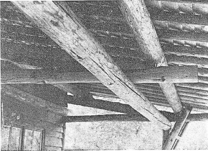
Ils constituent, avec la robuste cheminée et le carrelage en dalles d'usine — posées sur une aire en béton — les seuls éléments en maçonnerie du chalet.
