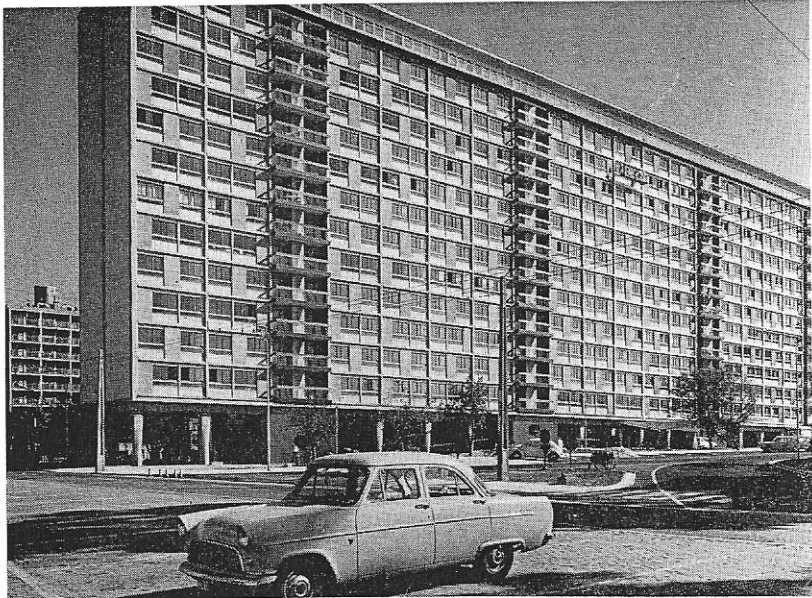
Vue d'ensemble du « bloc A ».
