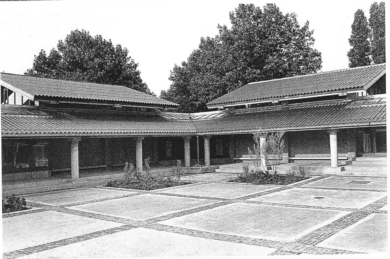
Une petite école dans un lotissement de banlieue. Photo Jean-Marie Dethier. La cour intérieure centrale: en partie espace ouvert (en relation avec les bâtiments qui l'entourent par le truchement du dessin géométrique du dallage), en partie espace intime (grâce à la conception de la galerie couverte). Photo Jean-Marie Dethier.
