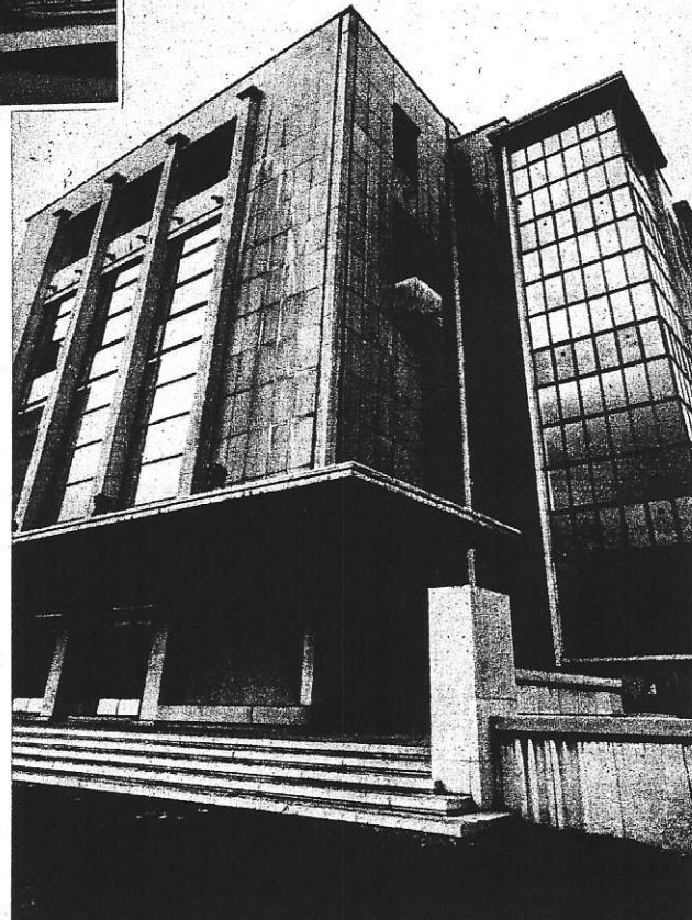
L'entrée monumentale de l'Institut du Génie Civil, vers le quai de Rome. Arch. Joseph Moutschen.
