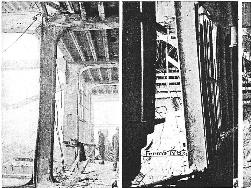
Fig. 75-76. Ferme I_{10} : poteau nj (à gauche). Ferme IV_6 : poteau du sous-sol (à droite).
