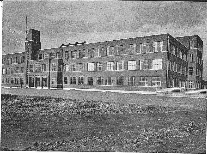
Fig. 457. Vue générale de l'Institut de Chimie et de Métallurgie.
