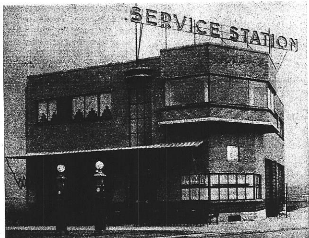
Relais automobile, à Liège. Arch. R. Kangiester, à Seraing. Parement en briques « Moderna » rugueuses, de ton jaune héliotrope, fournies par Kessels, à Bruxelles.
