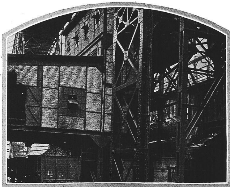
Fig. 21. — Vue d'ensemble extérieure du triage central.
