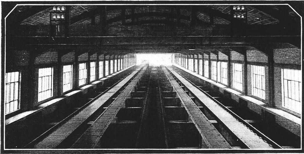
Fig. 49. — Accumulateurs à minerais. Vue d'ensemble au niveau d'arrivée des wagons automatiques à minerais.
