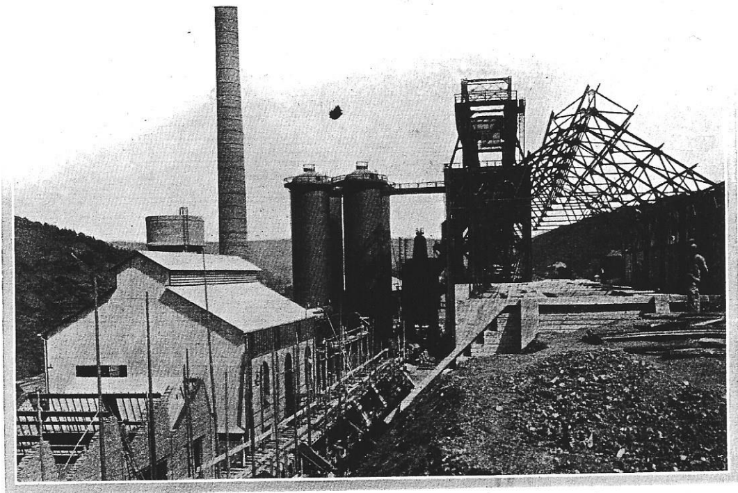
Fig. 66. — Vue d'ensemble d'un fourneau et de sa batterie de 4 Cowpers.
