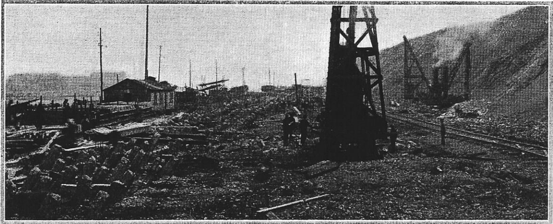
Fig. 18. — Fondations des accus à minerais. Battage de pilots inclinés.
