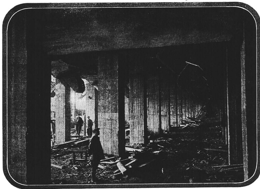
Fig. 11. — Silos à charbons. Vue des trémies.
