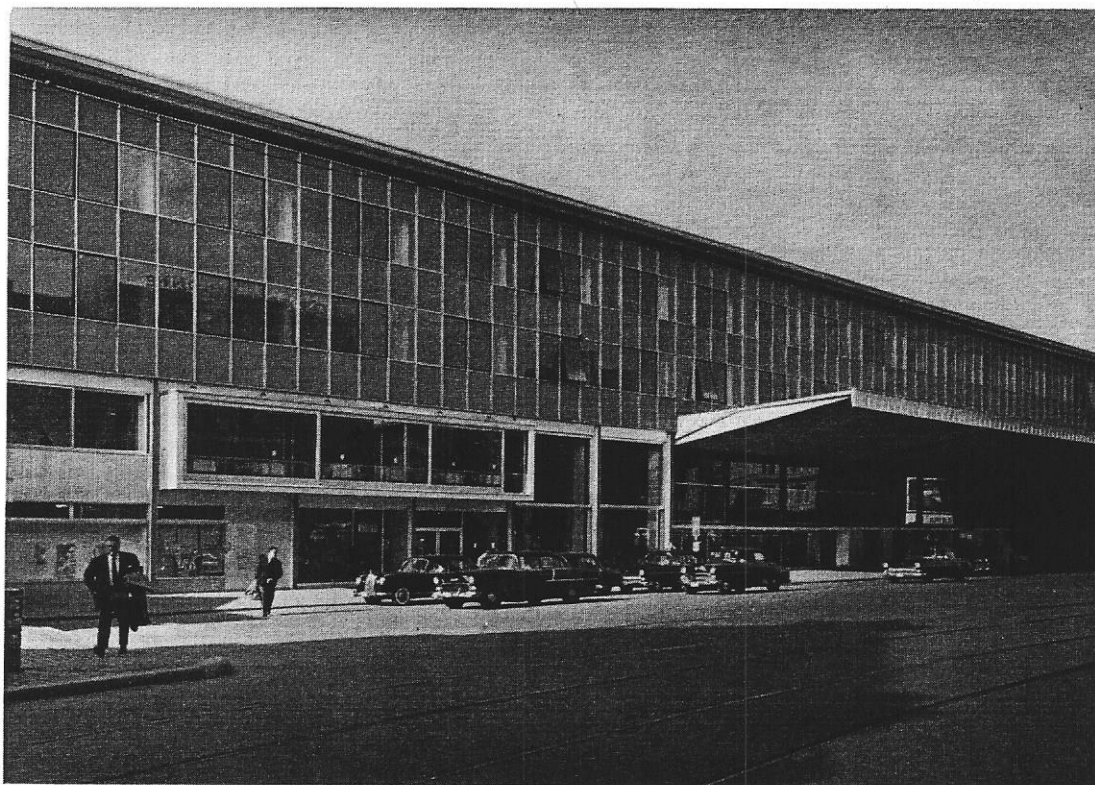
FIG. 1. — LA NOUVELLE GARE DES GUILLEMINS À LIÈGE. Vue de la façade du bâtiment des Recettes. La surface plane de la façade, presque entièrement vitrée, mesure 110 m de longueur sur 17 de hauteur; elle est compartimentée par des profilés d'aluminium et encadrée par un mince cordon de pierre calcaire et de béton largement débordant.
