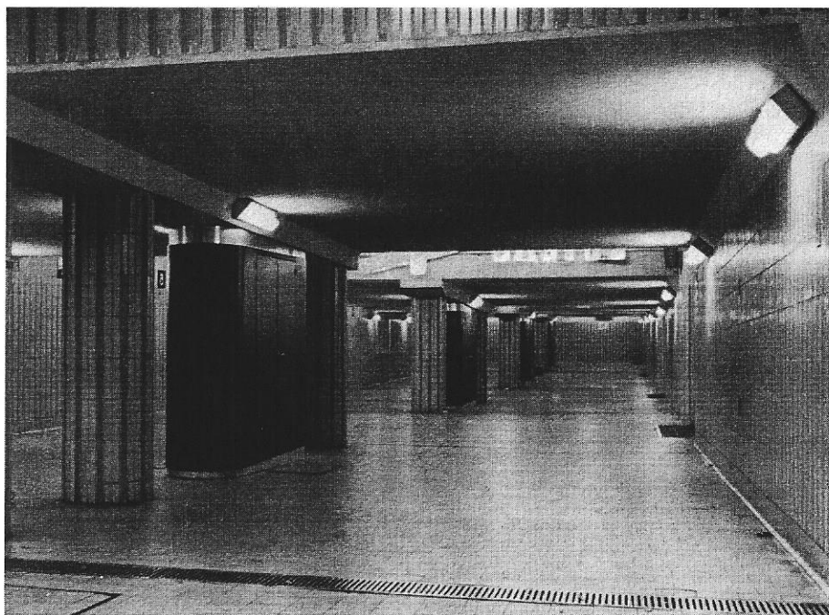
FIG. 16. — VUE D'UN COULOIR SOUTERRAIN DE COMMUNICATION ENTRE LES QUAIS.
