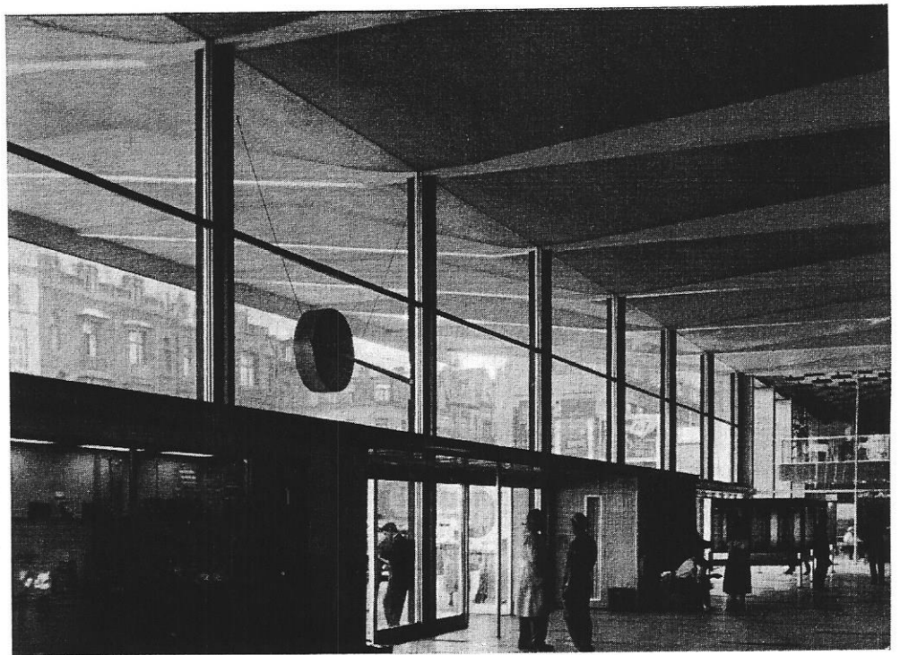
FIG. 10. — VUE DU HALL DES PAS-PERDUS, prise vers l'extérieur. Il convient de souligner la solution élégante du plafond de ce hall qui se prolonge vers l'extérieur, pour constituer l'auvent, sans qu'aucune poutre ne sépare ces deux éléments.
