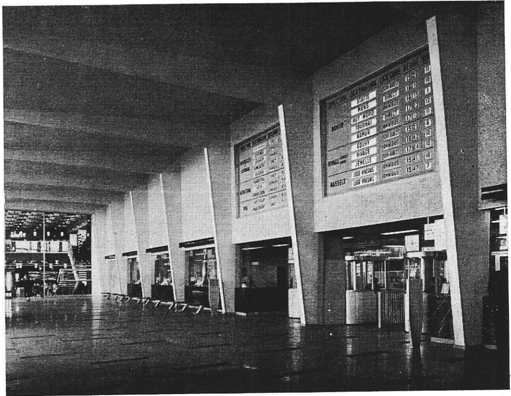
FIG 21. — VUE PARTIELLE DE LA SALLE DES PAS PERDUS montrant une partie des guichets et les portillons d'accès aux quais, au-dessus desquels on remarquera les tableaux horaires automatiques à commande électronique. Au fond, le restaurant.
