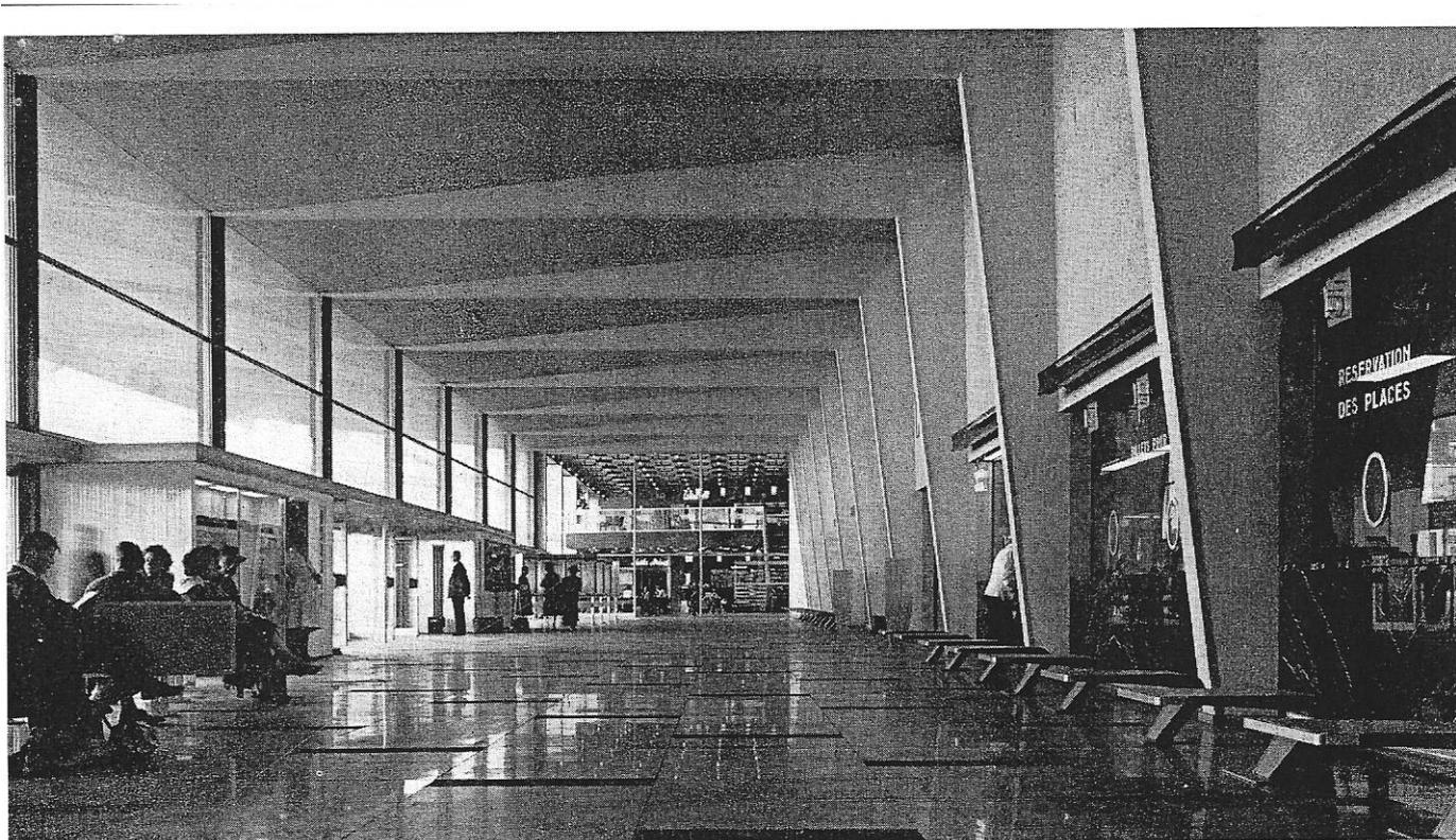
Hall des guichets : nervures et voile en béton de silex blanc bouchardé revêtus d'un vernis vinylique transparent. Dans le fond, la brasserie et le restaurant.
