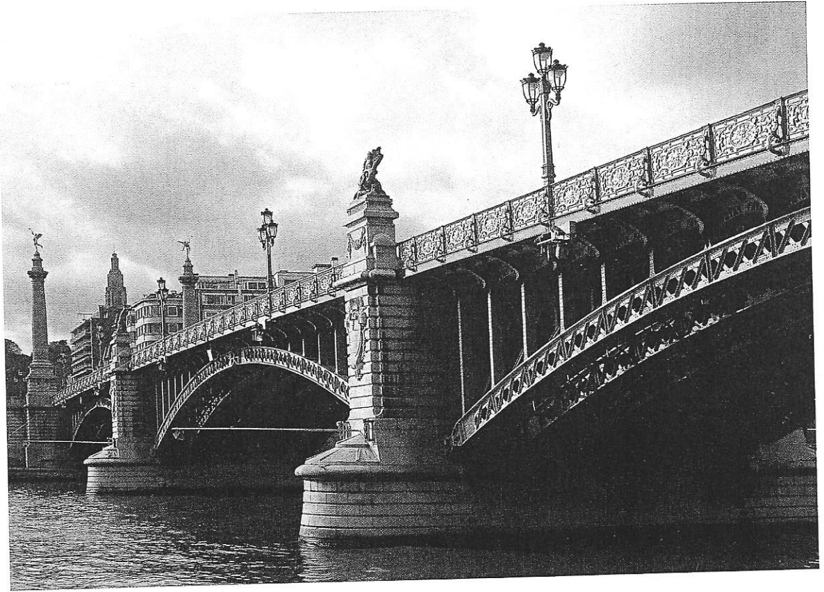
Le pont de Fragnée. Photo : Marc Verpoorten - Ville de Liège.
