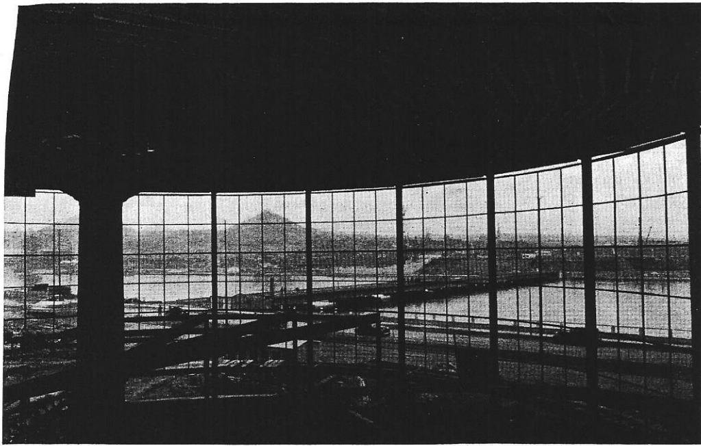
Fig. 12. — Vue intérieure de la Rotonde du Lido montrant la disposition de la structure intérieure - ossature principale en acier, dont le support essentiel est constitué par une colonne centrale en tôle d'acier. Ce pavillon abritera l'exposition de « plein air et parure ».
