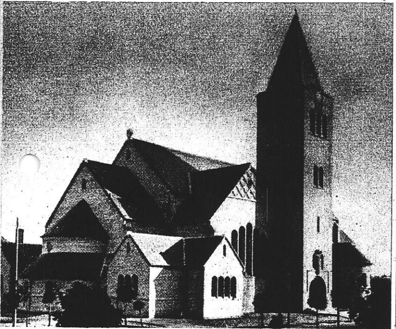
A gauche : Eglise Royale du Sacré-Cœur, à Knocke-Le Zoute. Arch. J. et L. Viérin, à Bruges. La toiture est exécutée en ardoises de 6 mm. d'épaisseur, du format 36/20, fixées au moyen de crochets en cuivre de 9 cm. X 4 mm. (Photo Watteyne.) A droite : Eglise de l'Annonciation, à Bruxelles. Arch. C. Damman. (Photo Sergysels.)
