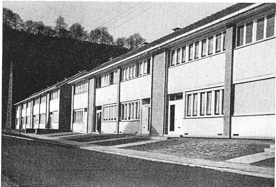
FIG. 8. — VUE D'ENSEMBLE D'UN GROUPE. Remarquer l'originalité des pilastres de renfort, en briques de Kleinspauwen (briques jaunes de parement). Les allèges de fenêtres, de belles proportions, sont revêtues d'un enduit à grains fins (Chromolith) d'un blanc cassé (ivoire).
