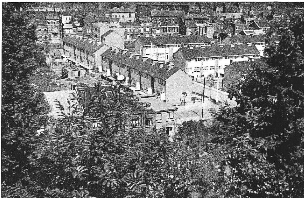
FIG. 1. — VUE PLONGEANTE PARTIELLE DES HABITATIONS DU « CHANTIER NATIONAL » D'ANGLEUR.
