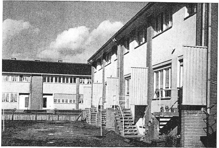
FIG. 7. — LES HABITATIONS D'ANGLEUR. Vue montrant, à droite, la façade vers jardin et, au fond, la façade sur rue d'une des groupes. Remarquer les cloisons de séparation, en plaques d'Eternit ondulé sur châssis en fer U; elles sont peintes de couleurs vives, différentes par groupes de maisons.
