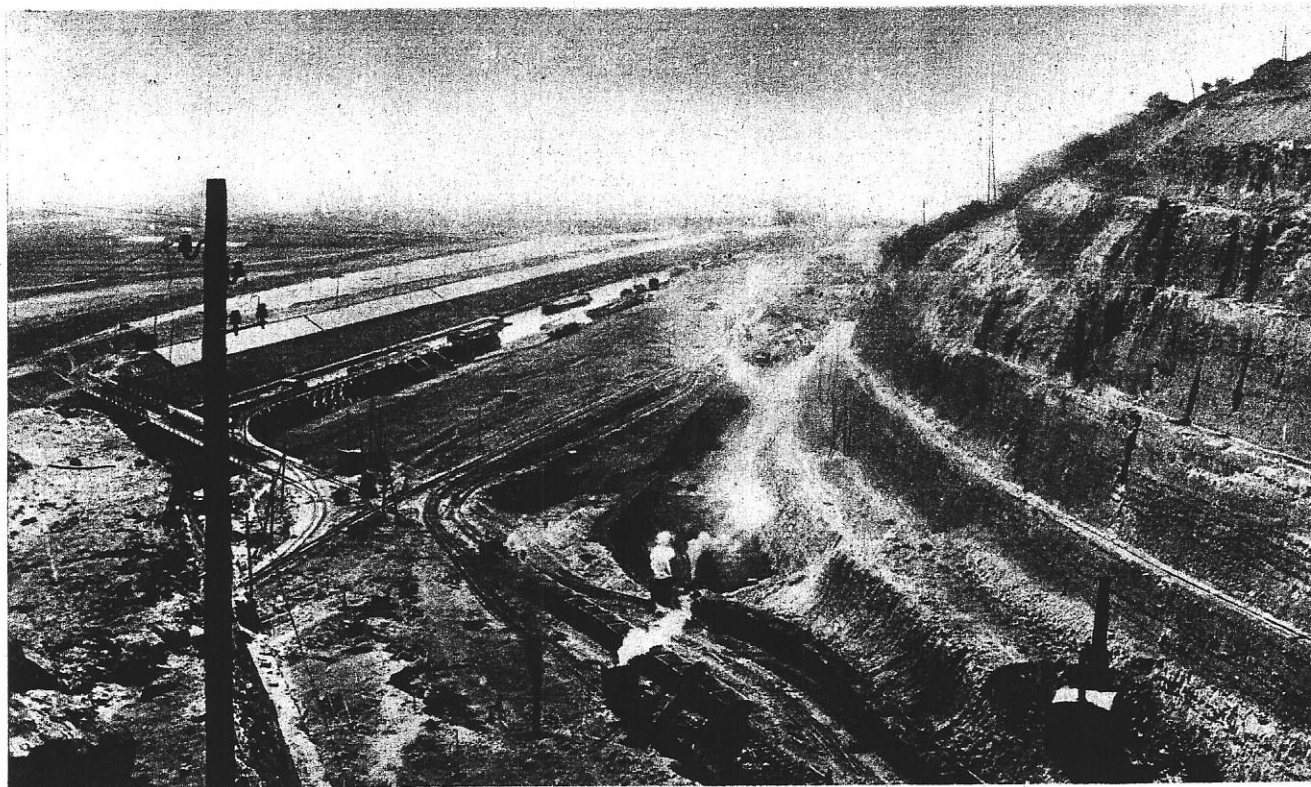
VUE VERS PETIT-LANAYE ET VISE; DEBUT DE LA TRANCHEE MEUSE-GEER. DIGUES EN TERRE TERMINEES. AU FOND, CANAL DE LIEGE A MAESTRICT.
