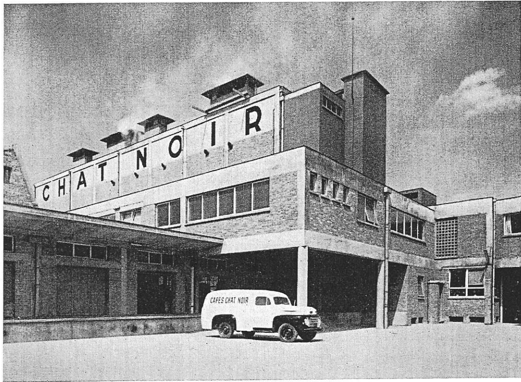
FIG. 8. — VUE PRISE DE LA COUR INTÉRIEURE, vers la salle de torréfaction. Le départ des camions et le quai de déchargement.
