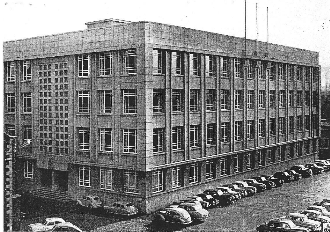
Fig. 2. Vue d'angle montrant les façades Nord et Ouest du nouveau bâtiment administratif de la S. A. John Cockerill à Seraing.
