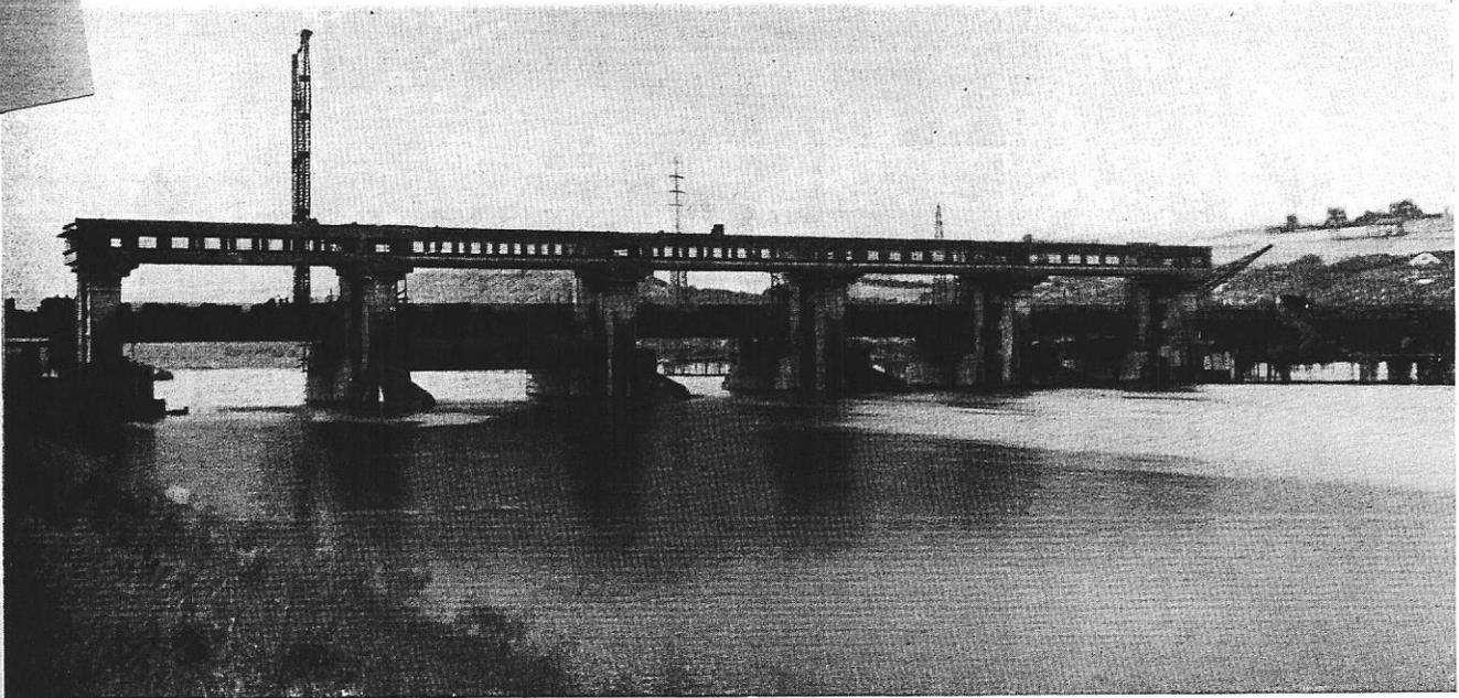
Fig. 1. — Vue d'ensemble du barrage, prise de l'amont. La flottaison est environ 62,45 au moment de la prise de vue ; le barrage relèvera ainsi le plan d'eau de 2 m.
