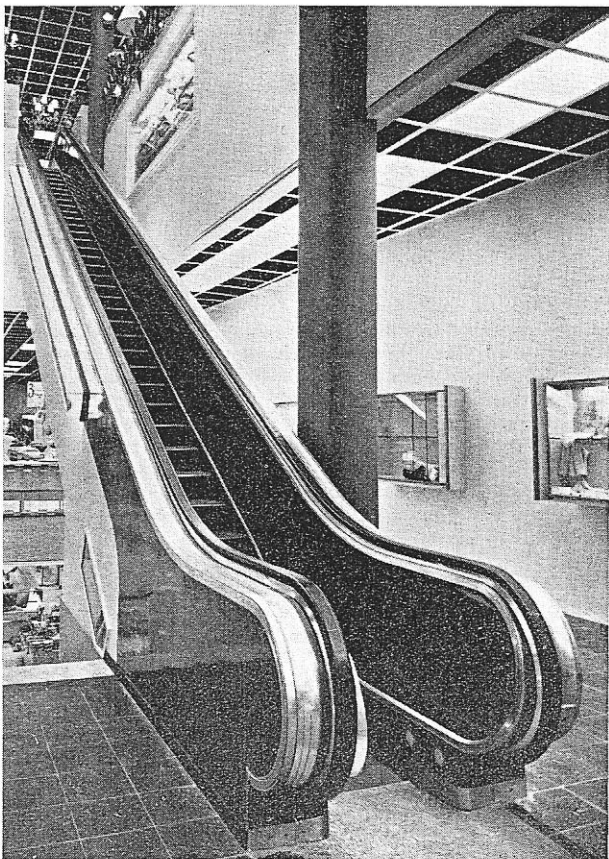
L'escalator permet d'accéder rapidement au premier étage.
